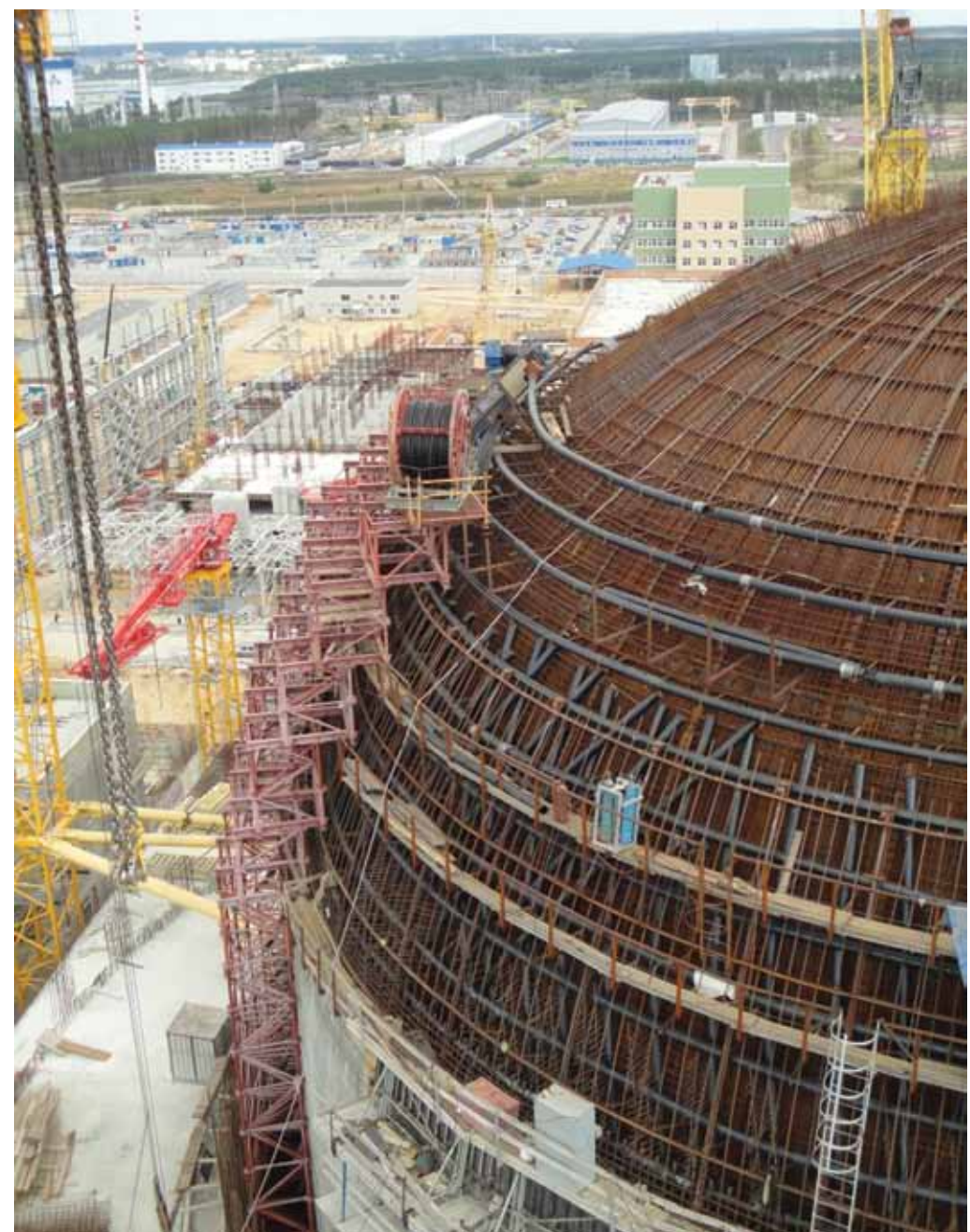
Рис. 5 Монтаж армопучков на НВАЭС-2
